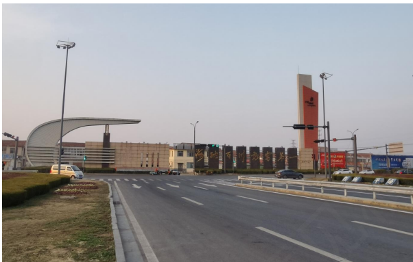
赣榆高速出入口现状
